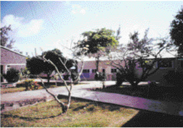
Figure 4 - Hôpital central de Crèvecoeur à Port-Mathurin.
